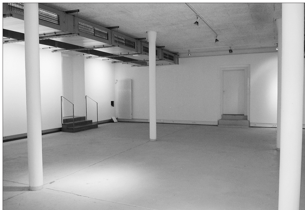
Die Grundinstandsetzung der neuen Location in Aubing an der Ubostraße 9 umfasst den Einbau einer Heizung und Lüftungsanlage, die Einrichtung von Toiletten, akustische Verbesserungen, neue Elektrik sowie den Umbau der Räume, damit sie barrierefrei begehbar sind. Foto: Martina Krämer
