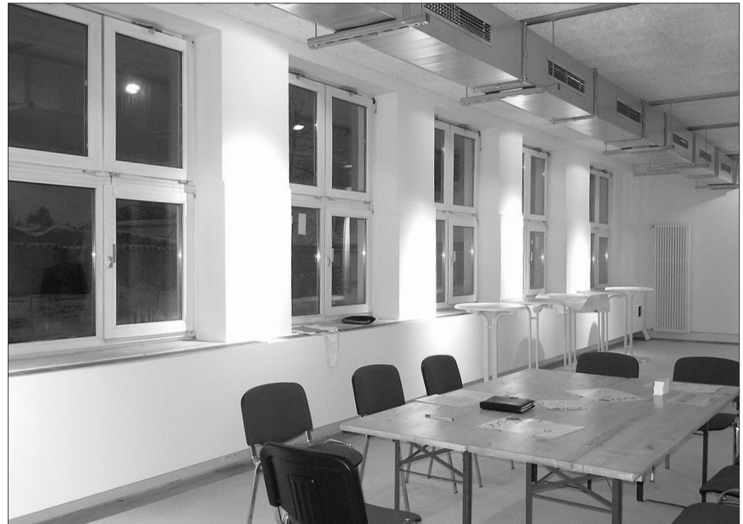
Die alten Fenster sind wieder zu sehen. Sie werten einladend die Seminarräume 1 und 2 zu hellen und ansprechenden Räumen für Ausstellungen, Tagungen oder Sitzungen auf. Foto: Martina Krämer
